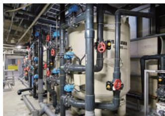
除鉄・除マンガンろ過装置活性炭ろ過装置
