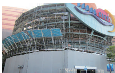
外壁改修工事(キャナルシティ博多)
