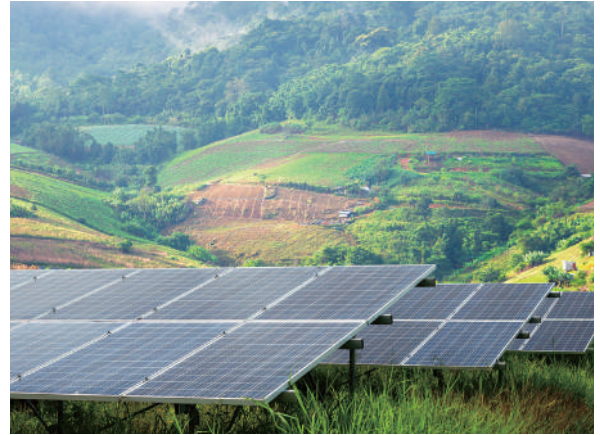
太陽光発電設備工事
