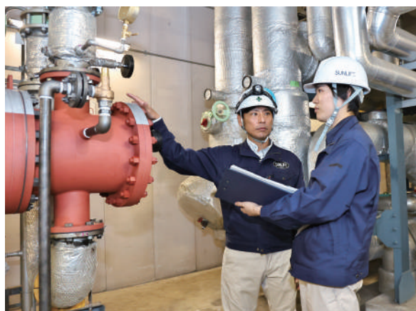
熱源設備改修工事
