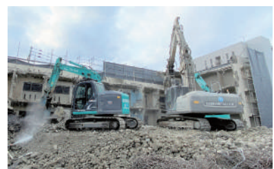
解体工事(某銀行社宅)
