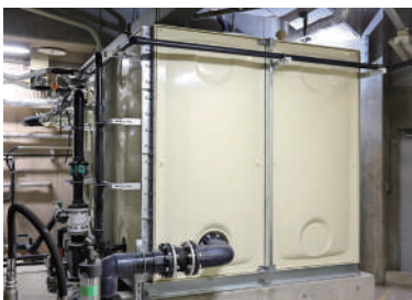
井戸水処理水槽 汲み上げた井戸水をB2Fプラント内の水槽に貯留。
