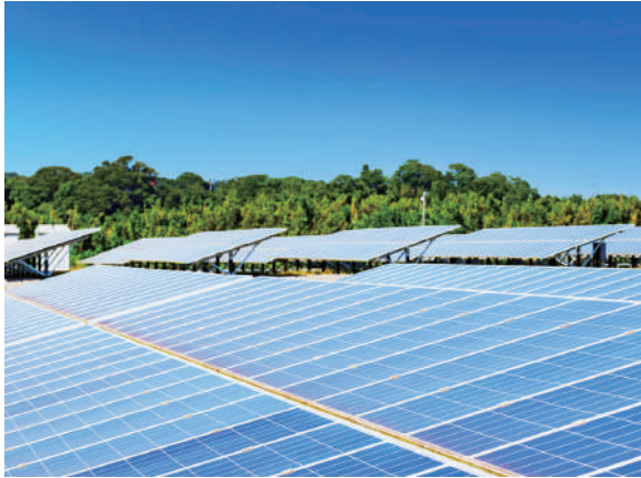
太陽光発電設備工事
