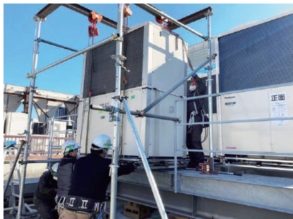
空調設備改修工事
