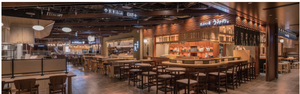
内装工事(天神ビジネスセンター地下2階 イナチカ共用部)
