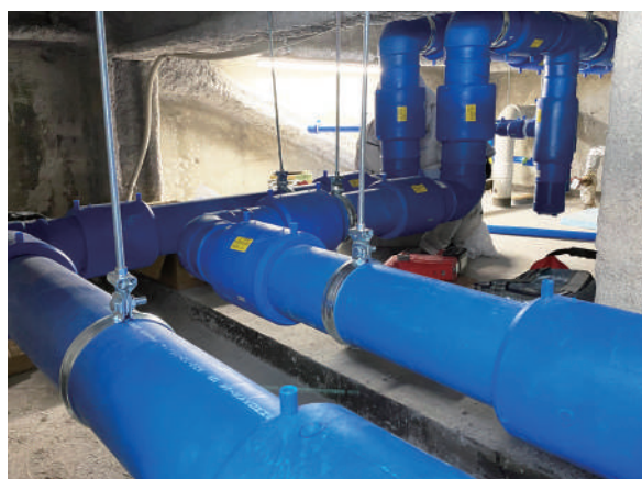
給排水・衛生配管更新工事
