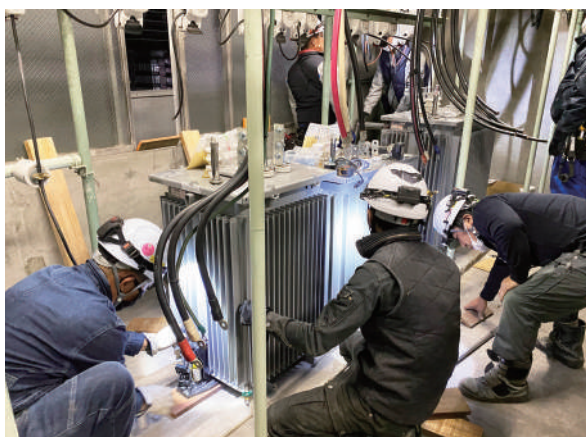
受変電設備更新工事
