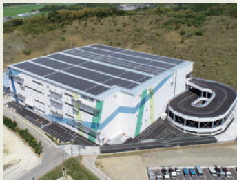
ロジシティ古賀 福岡県古賀市
