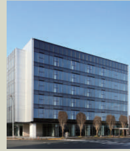
東比恵ビジネスセンター II 福岡市博多区
