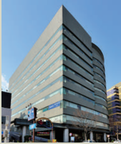
キャナルシティ ビジネスセンタービル 福岡市博多区
