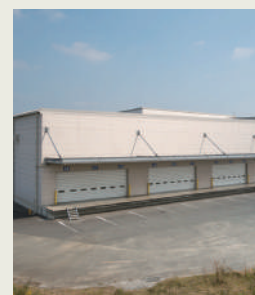
ロジシティ若宮 福岡県宮若市
