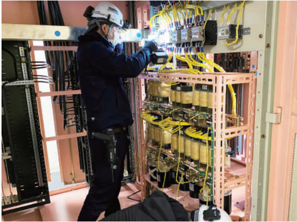
受変電設備更新工事
