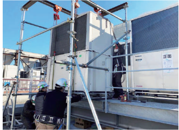
空調設備改修工事
