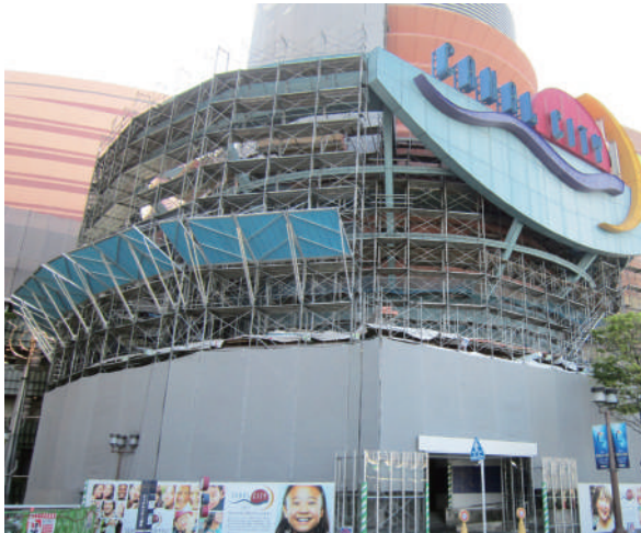
外壁改修工事(キャナルシティ博多)
