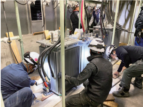
受変電設備更新工事
