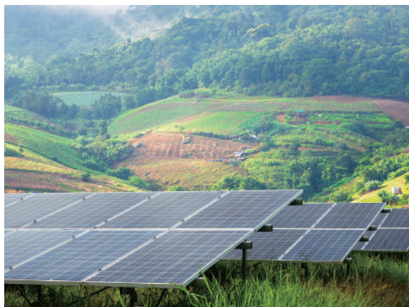
太陽光発電設備工事
