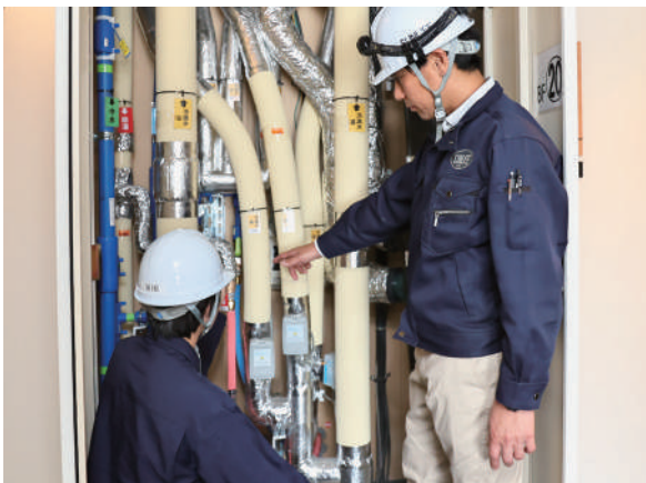
給排水・空調・衛生配管更新工事
