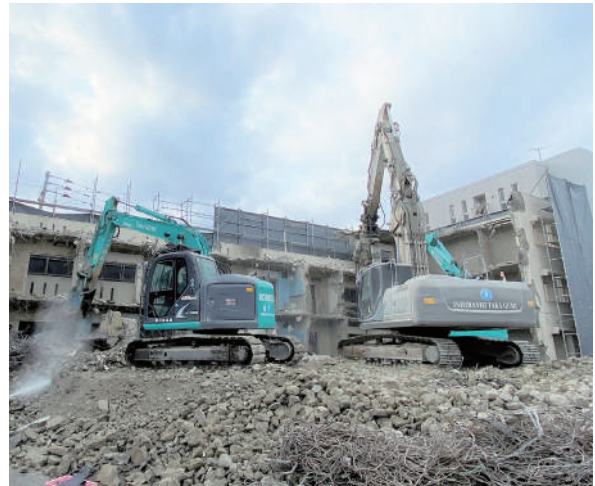
解体工事(佐賀銀行今川社宅)
