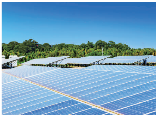
太陽光発電設備工事
