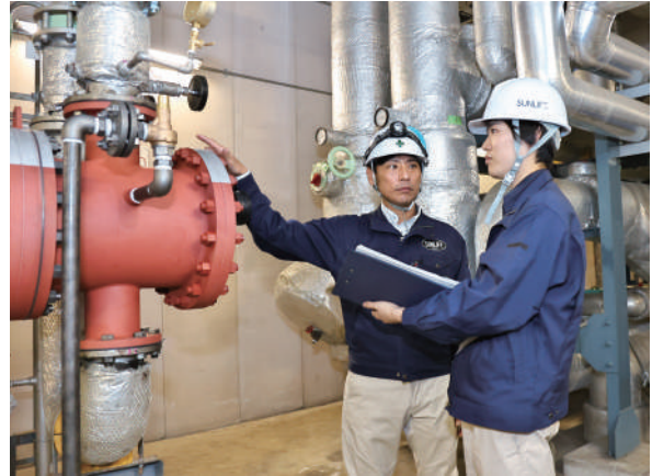
熱源設備改修工事
