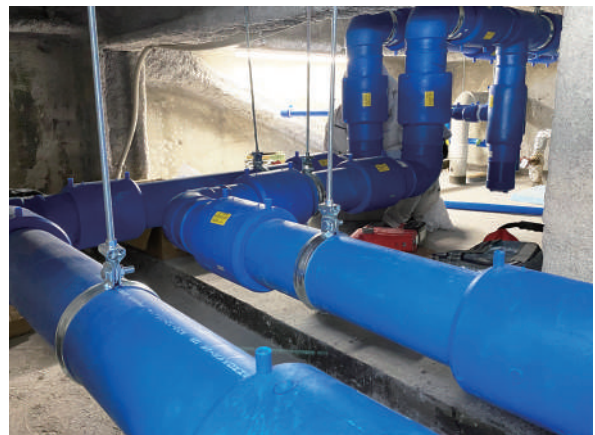
給排水・衛生配管更新工事
