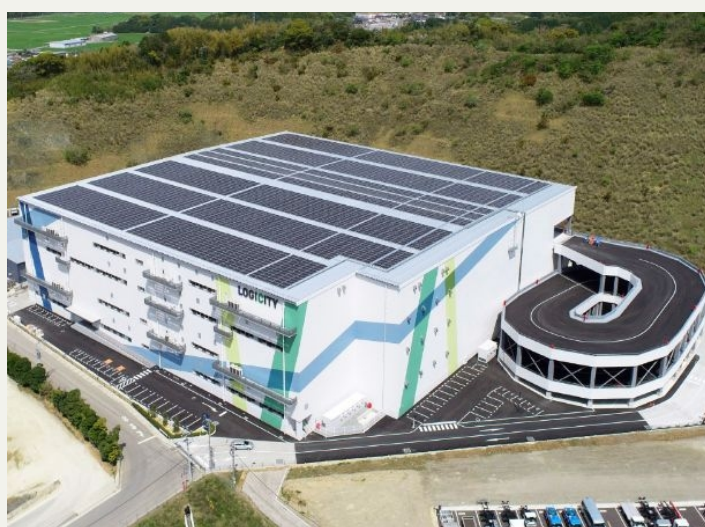
ロジシティ古賀 福岡県古賀市
