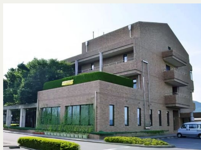
糸島市交流プラザ二丈館 糸島市
