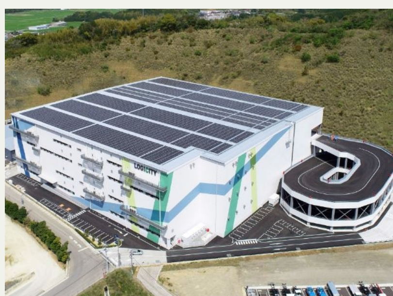
ロジシティ古賀 福岡県古賀市
