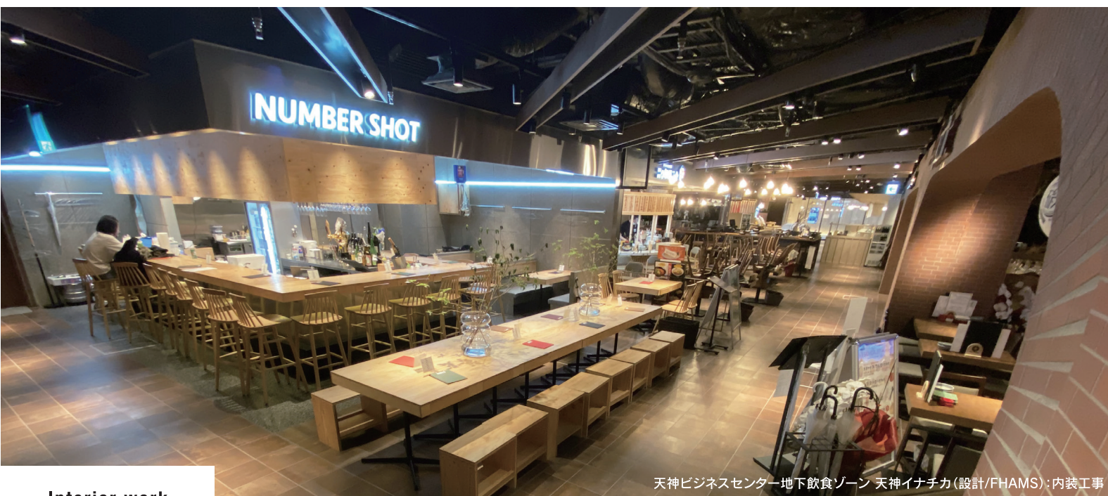
Interior work 【商業施設 内装工事】
