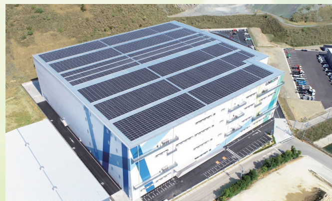
●設置方式: 屋根置き
