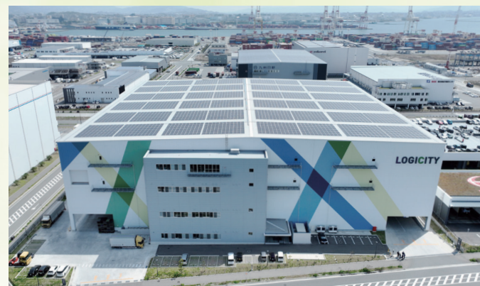
●設置方式: 屋根置き
