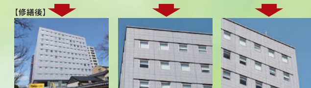
遠景：南側（地上から見る） 補修状況 補修状況
