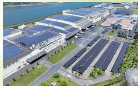
●設置方式：屋根置き・カーポート
