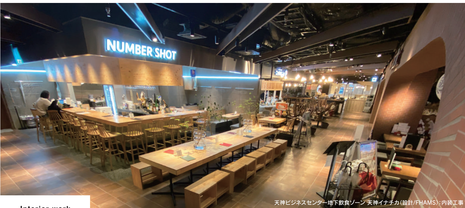
Interior work 【商業施設 内装工事】
