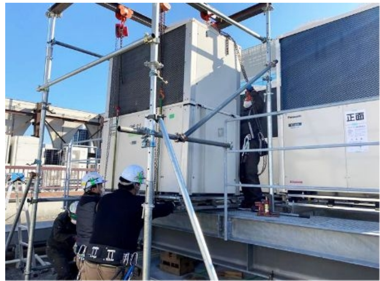
空調設備改修工事
