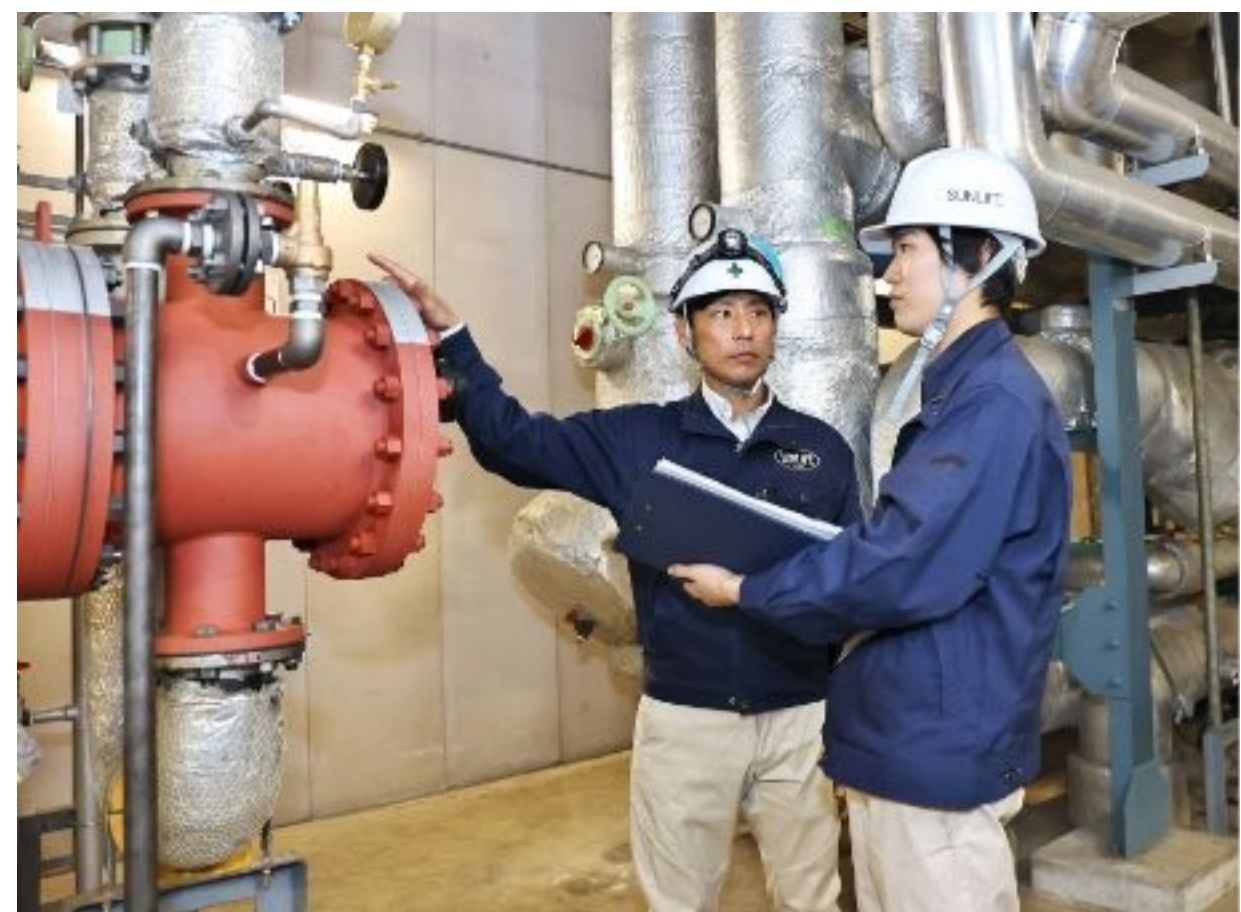
熱源設備改修工事
