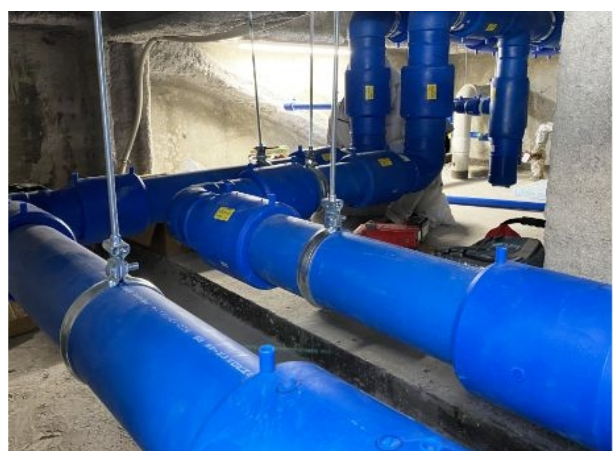
給排水・衛生配管更新工事
