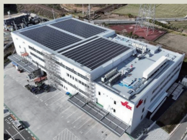
設置方式：屋根置き 福岡県筑紫野市
