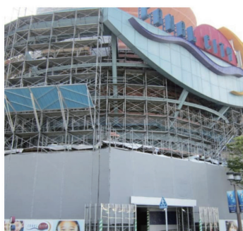
外壁改修工事(キャナルシティ博多)
