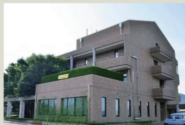
糸島市交流プラザ二丈館 糸島市
