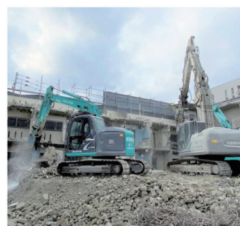
解体工事(某銀行社宅)
