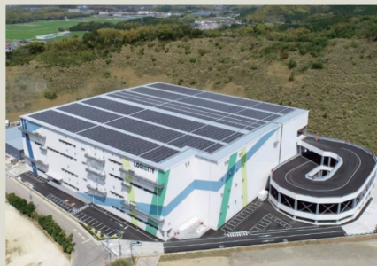
ロジシティ古賀 福岡県古賀市
