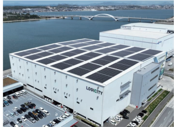
設置方式: 屋根置き
