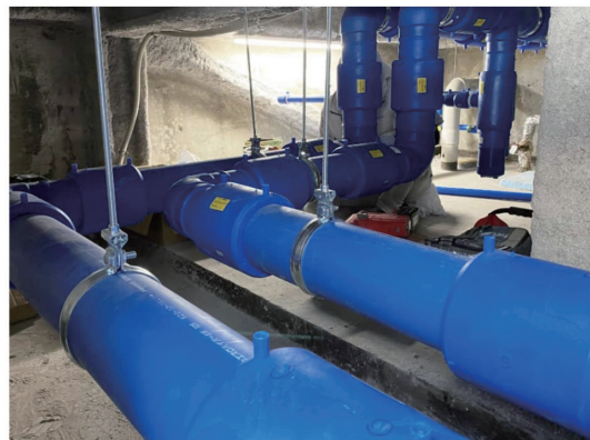
給排水・衛生配管更新工事
