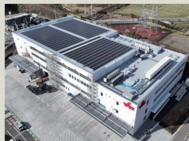
設置方式：屋根置き 福岡県筑紫野市
