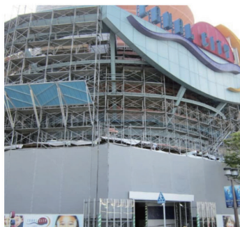
外壁改修工事(キャナルシティ博多)
