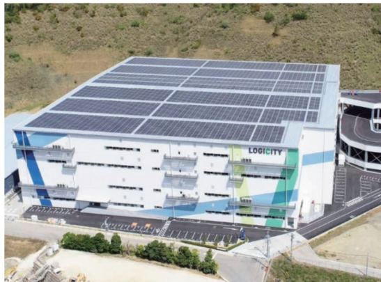
設置方式: 屋根置き
