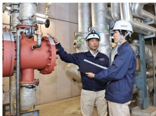
熱源設備改修工事
