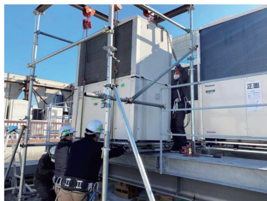
空調設備改修工事
