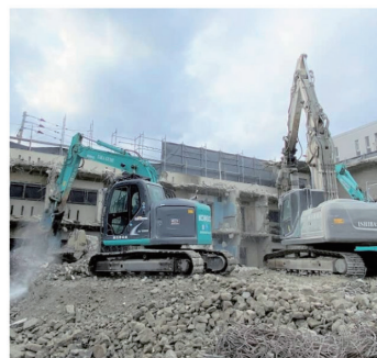
解体工事(某銀行社宅)
