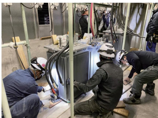
受変電設備更新工事
