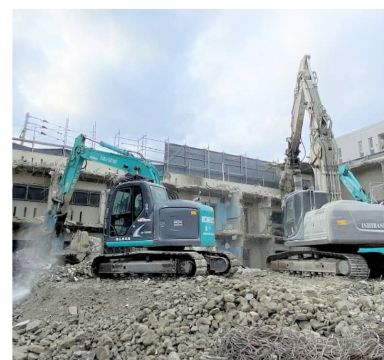
解体工事(某銀行社宅)
