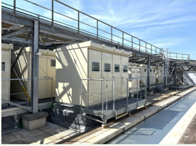
キャナルシティ博多ビジネスセンター：キュービクル更新工事 福岡市博多区
