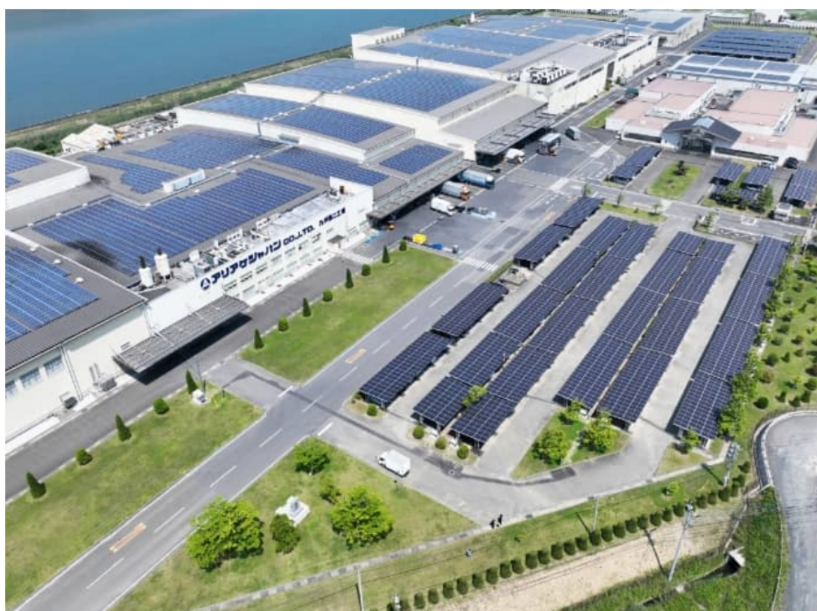
設置方式：屋根置き・カーポート
