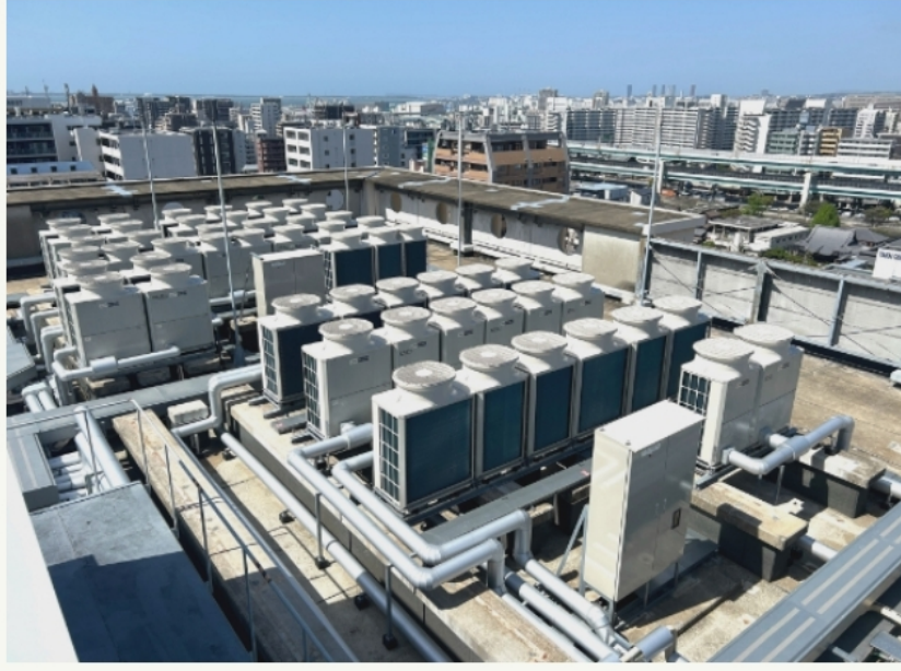
呉服町ビジネスセンタービル：空調機更新工事 福岡市博多区
