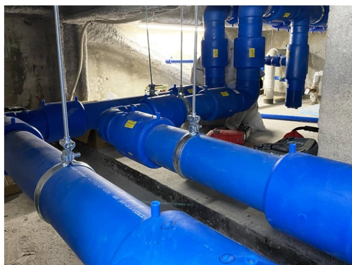
給排水・衛生配管更新工事
