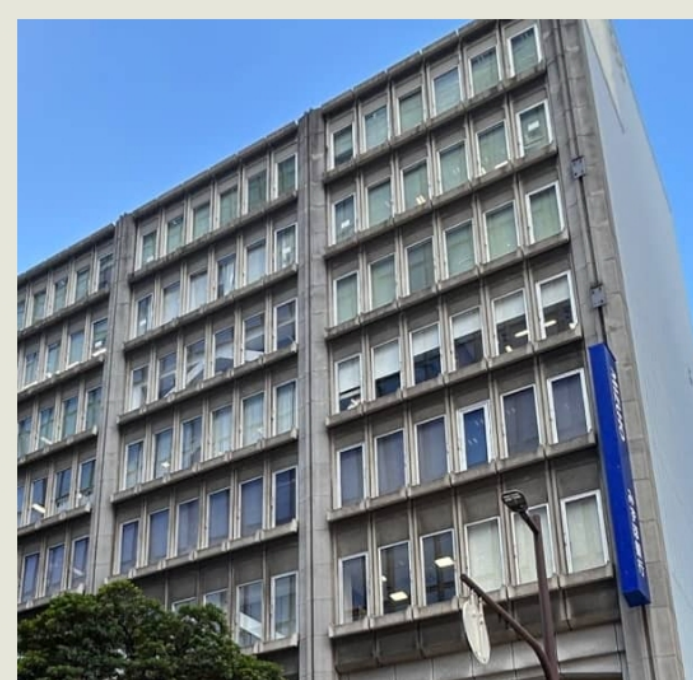
福岡興銀ビル 福岡市中央区
