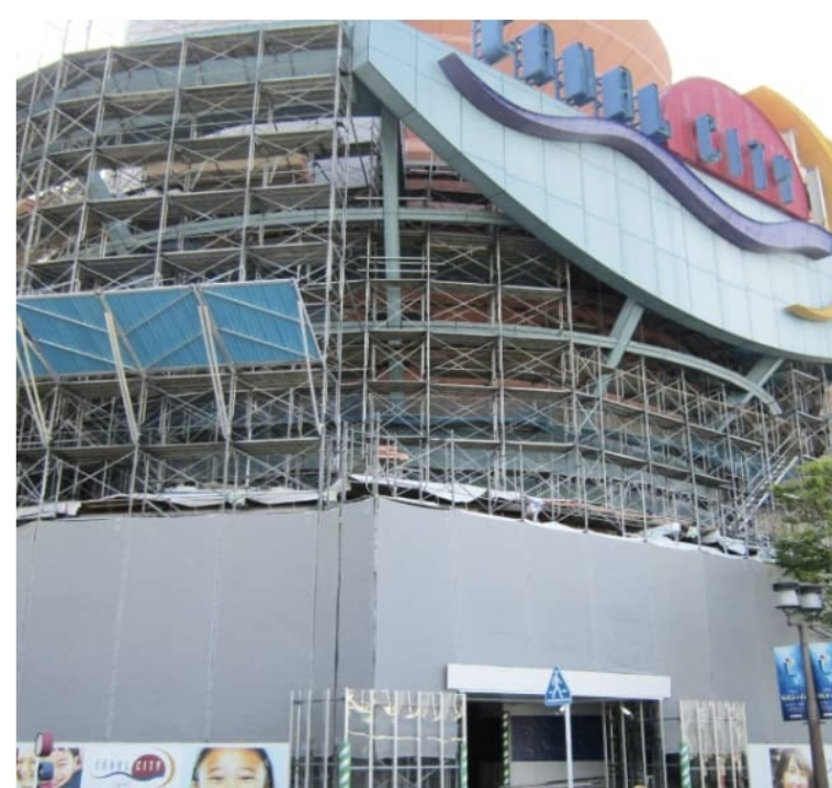
外壁改修工事(キャナルシティ博多)
