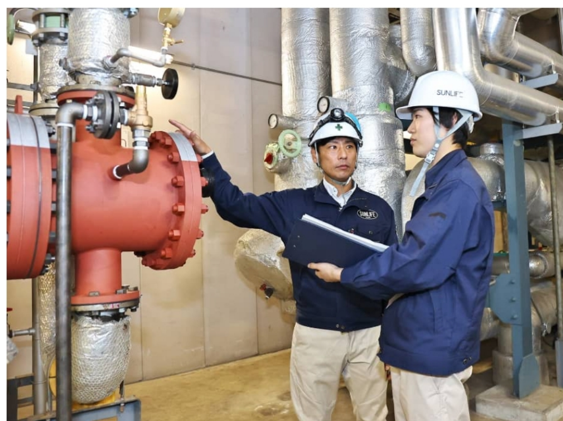
熱源設備改修工事
