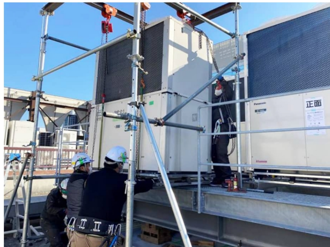
空調設備改修工事
