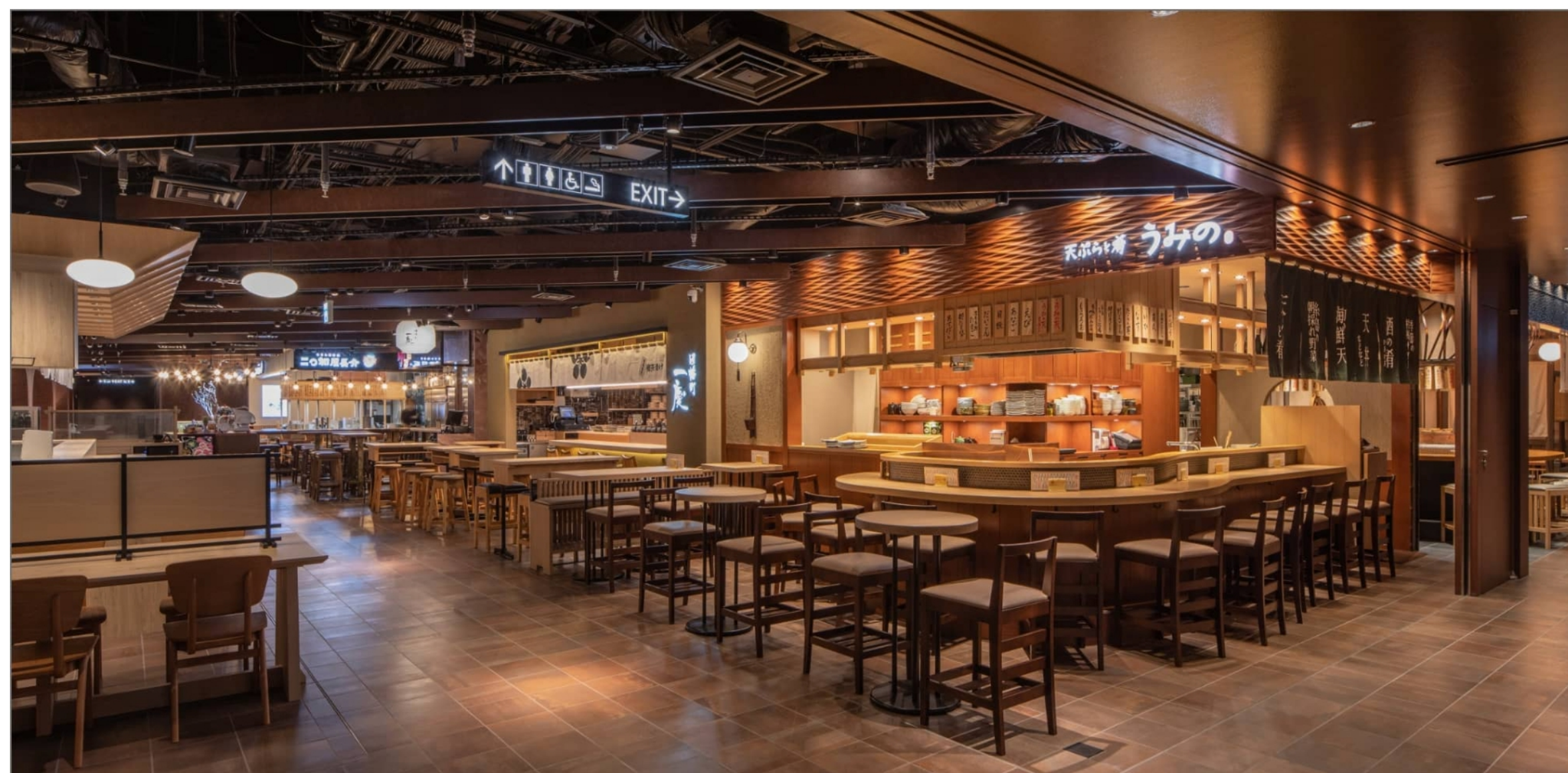
内装工事(天神ビジネスセンター地下2階 イナチカ共用部)
