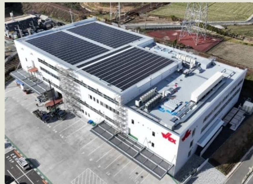
設置方式：屋根置き 福岡県筑紫野市
