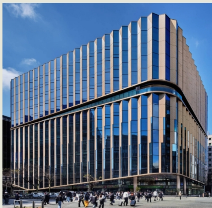
西日本シティビル 福岡市博多区
