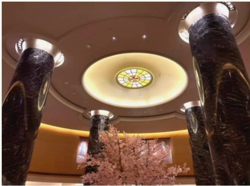
ホテルオークラ福岡：LED更新工事 福岡市博多区
