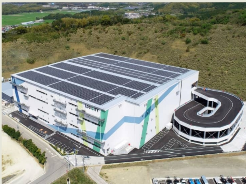
ロジシティ古賀 福岡県古賀市
