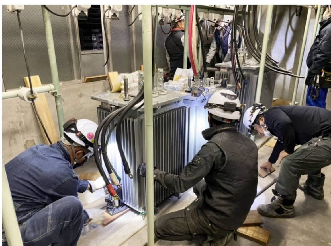
受変電設備更新工事
