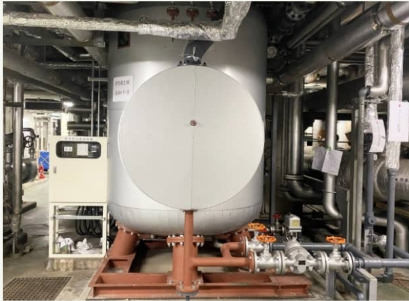
ホテルオークラ福岡： 熱源設備改修工事 福岡市博多区
