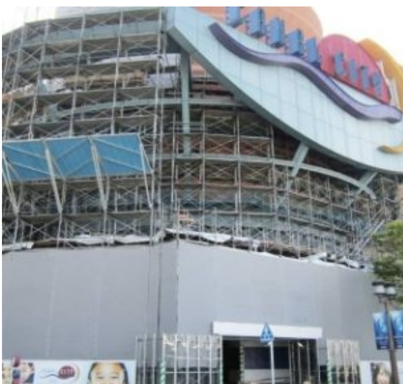
外壁改修工事（キャナルシティ博多）
