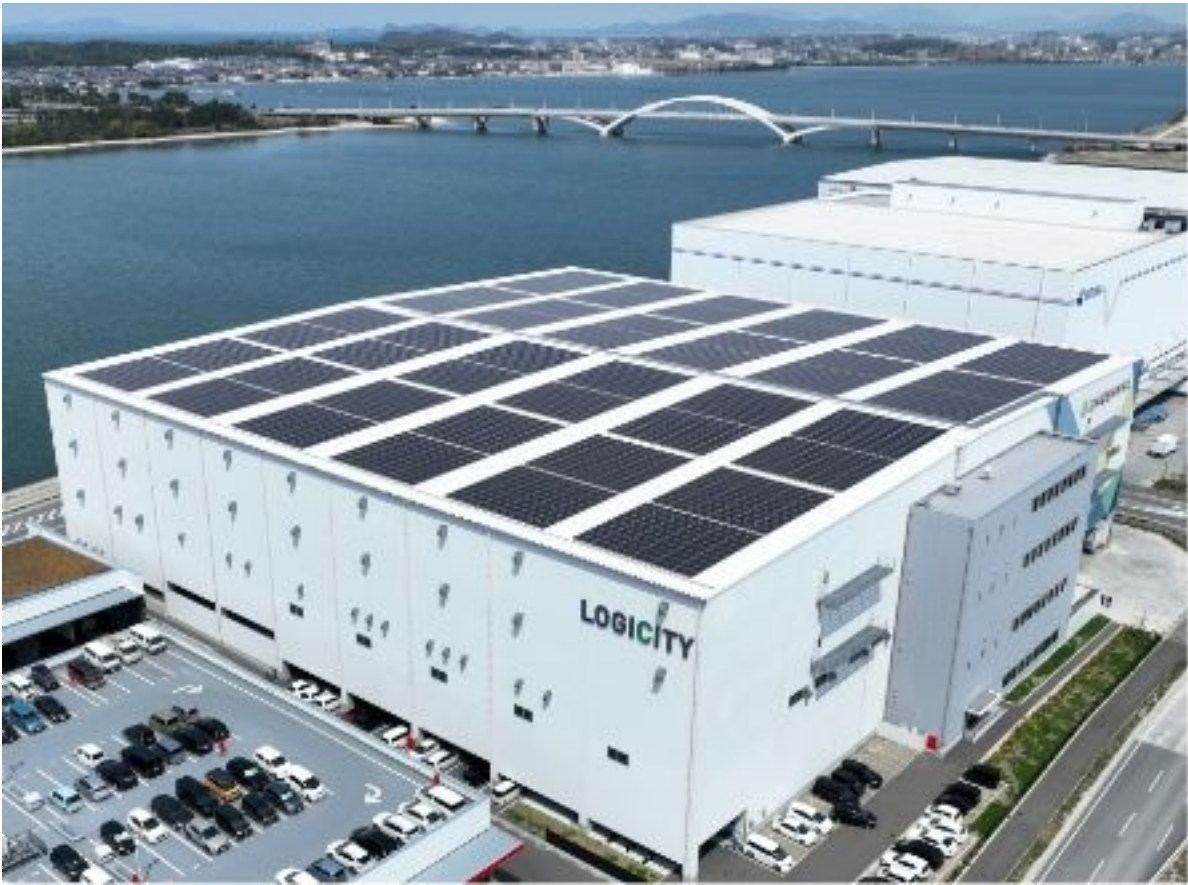
設置方式：屋根置き
