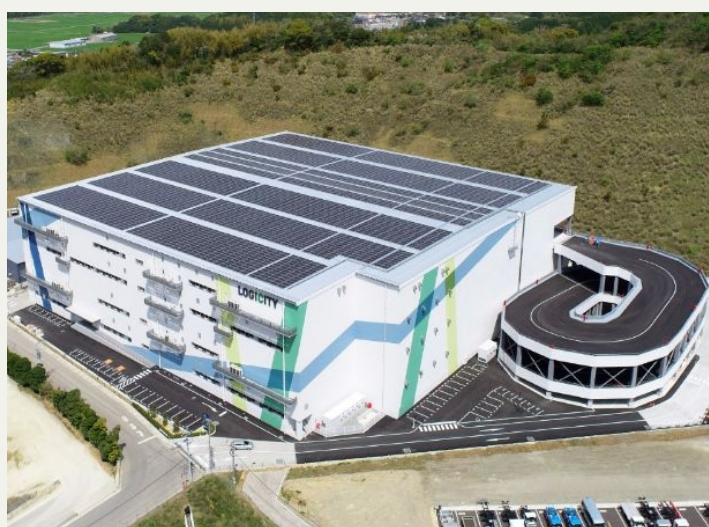
ロジシティ古賀 福岡県古賀市
