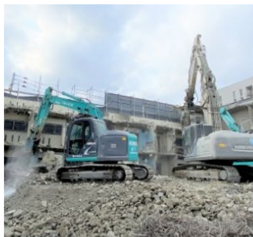
解体工事（某銀行社宅）
