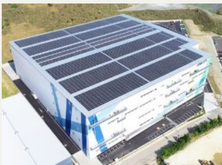
設置方式：屋根置き 福岡県古賀市
