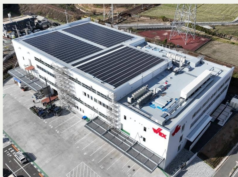
設置方式：屋根置き 福岡県筑紫野市
