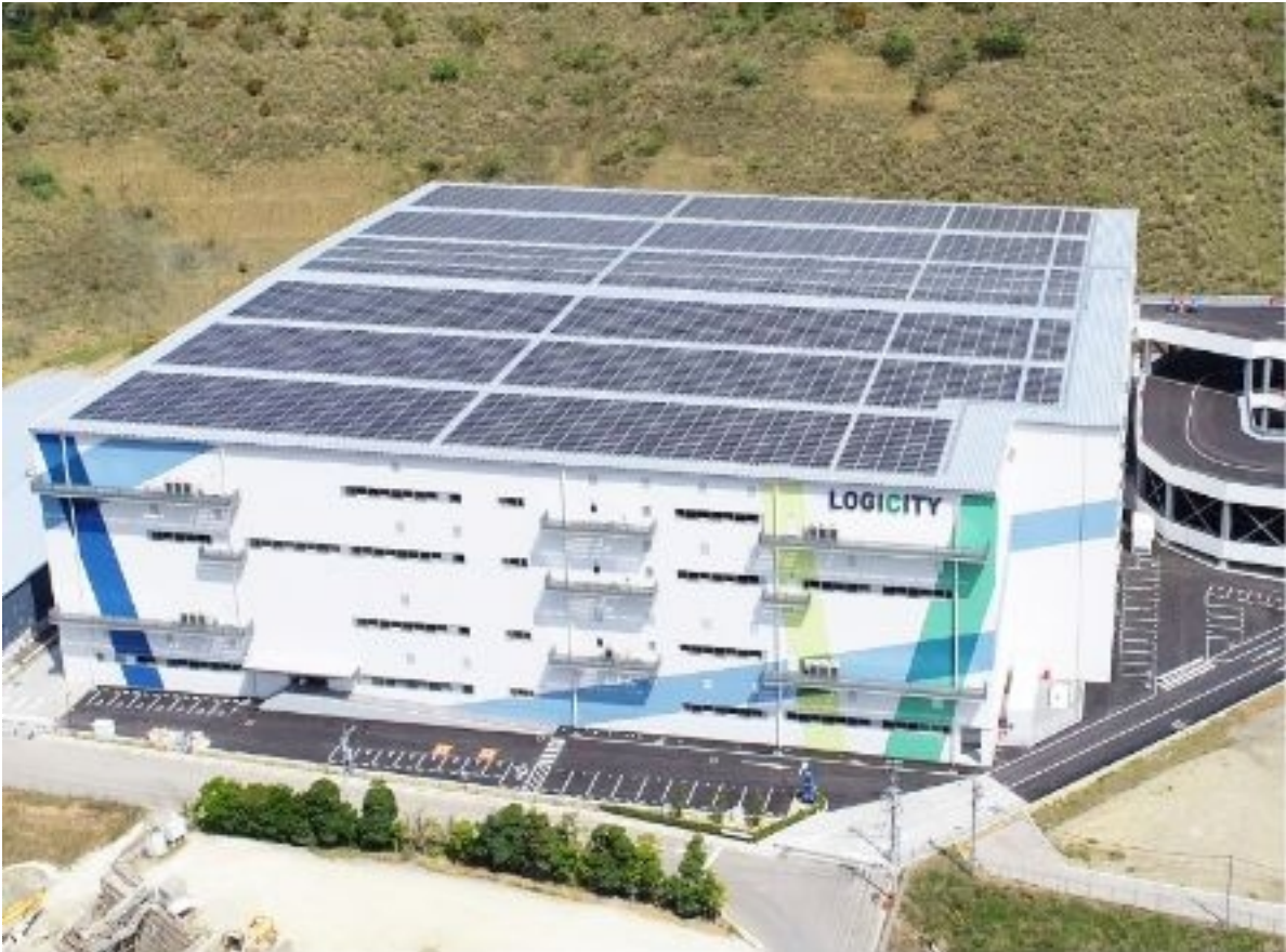
設置方式：屋根置き
