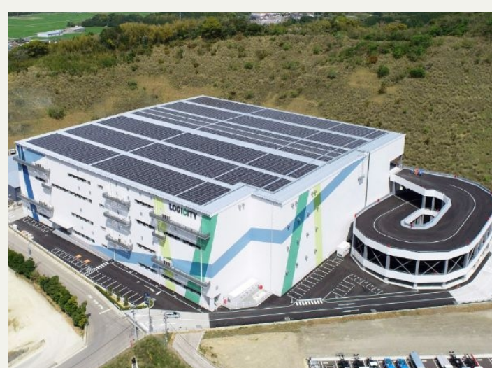
ロジシティ古賀 福岡県古賀市
