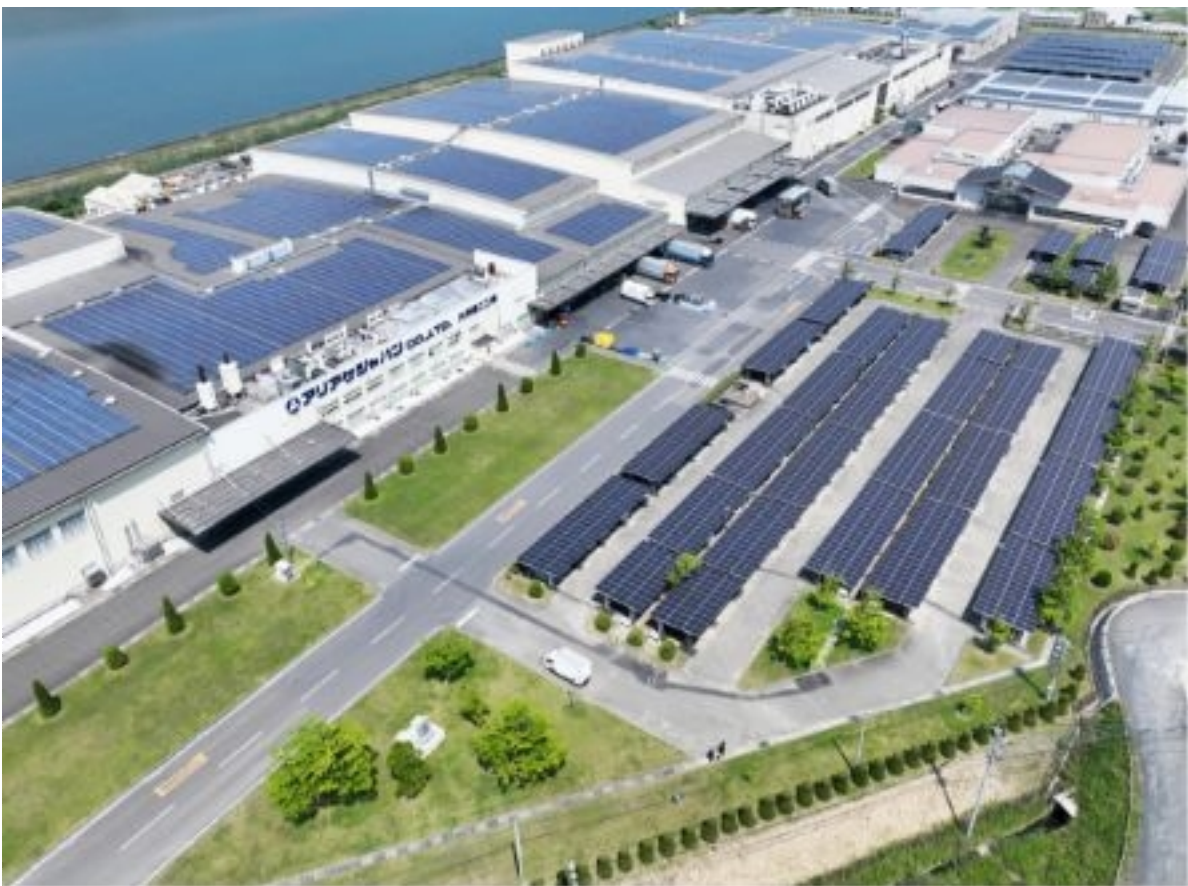
設置方式：屋根置き・カーポート
