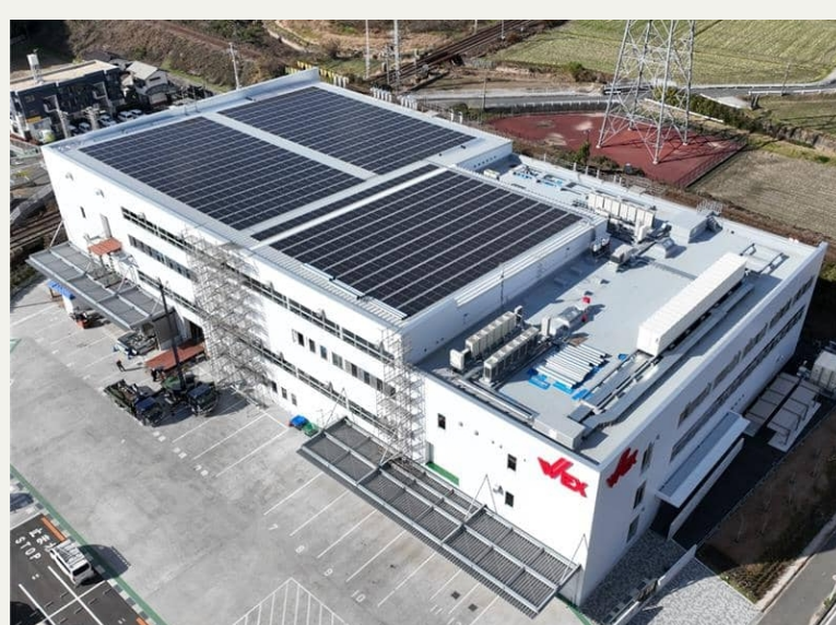
設置方式：屋根置き 福岡県筑紫野市
