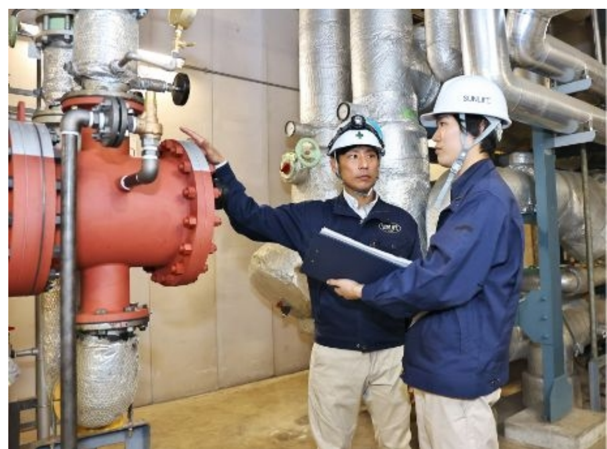
熱源設備改修工事
