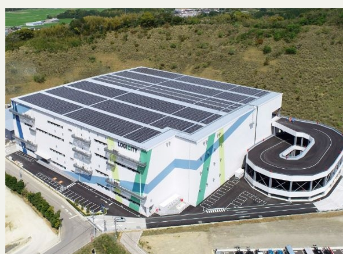
ロジシティ古賀 福岡県古賀市
