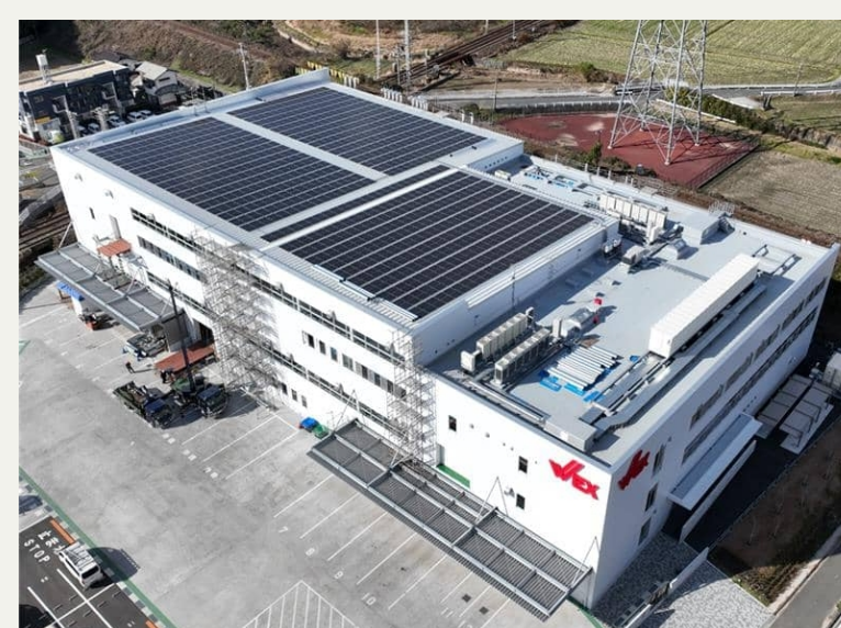
設置方式：屋根置き 福岡県筑紫野市
