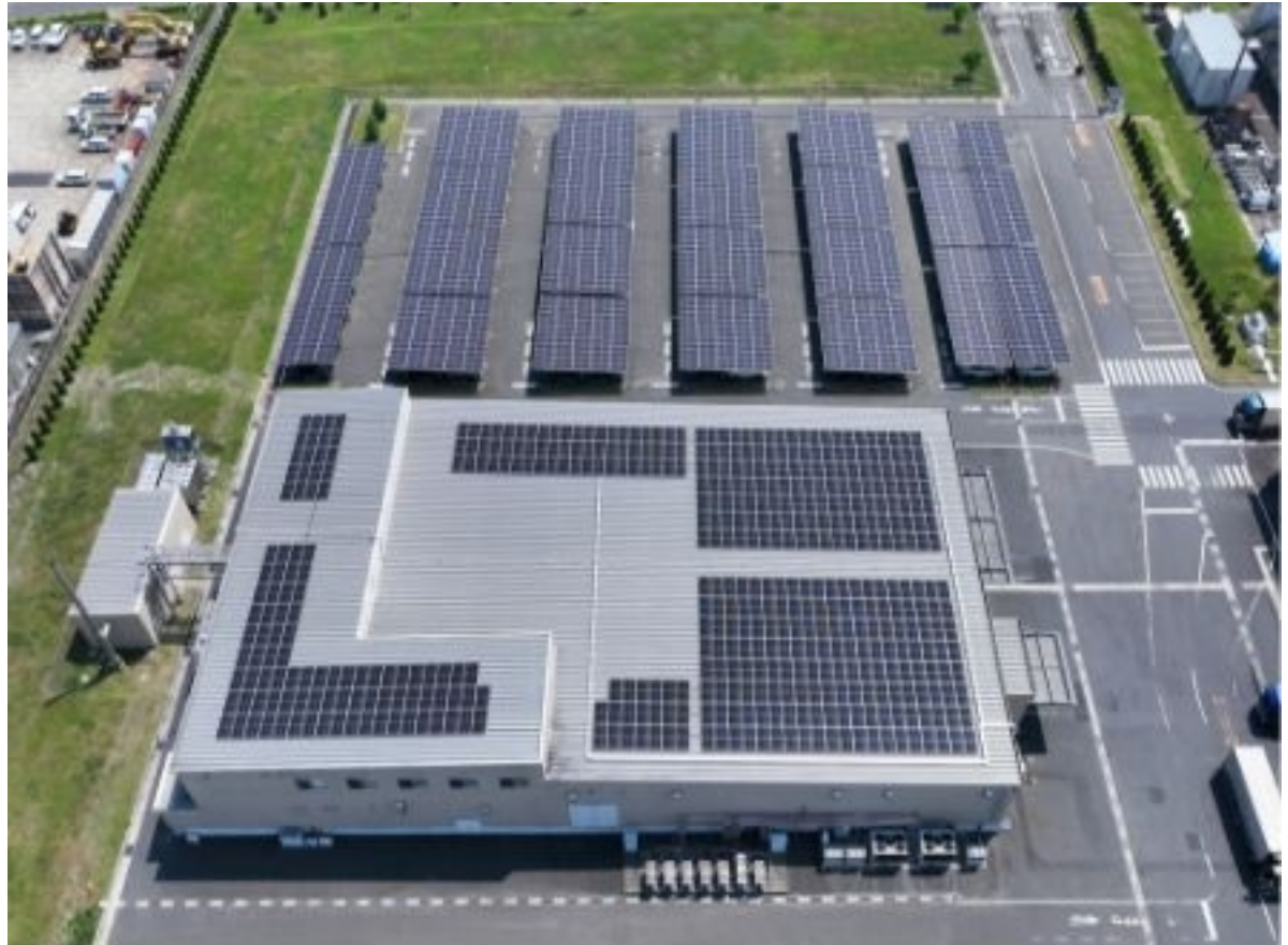
設置方式：屋根置き・カーポート
