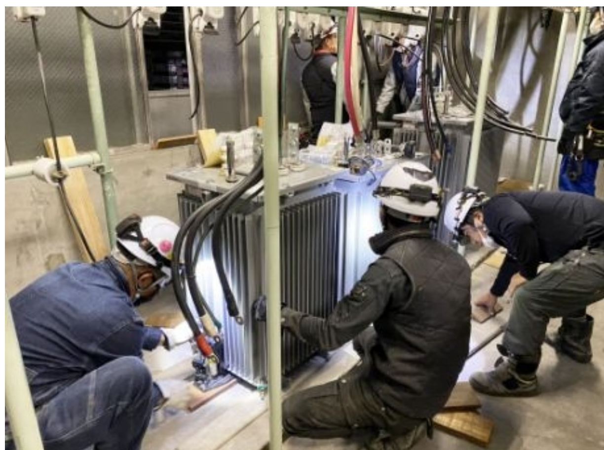
受変電設備更新工事
