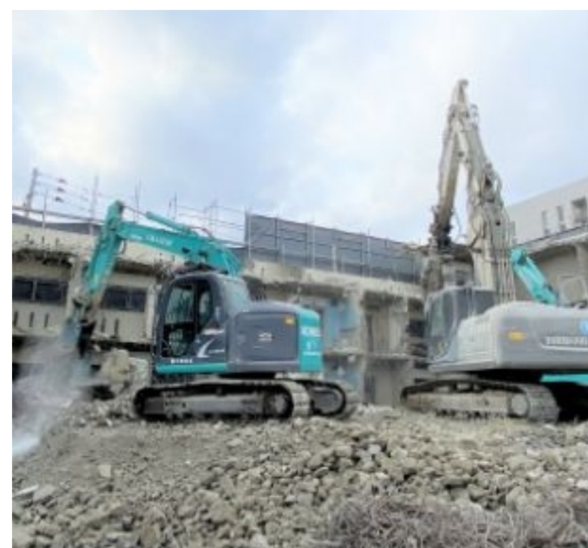
解体工事（某銀行社宅）
