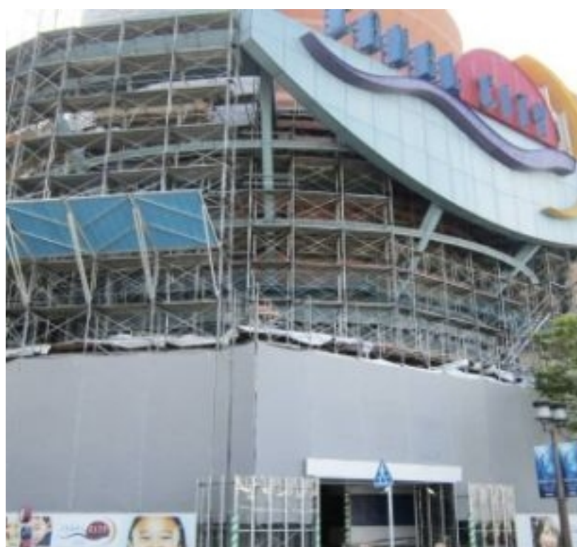
外壁改修工事（キャナルシティ博多）
