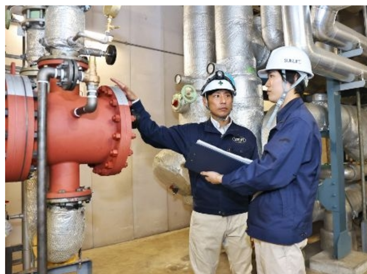
熱源設備改修工事
