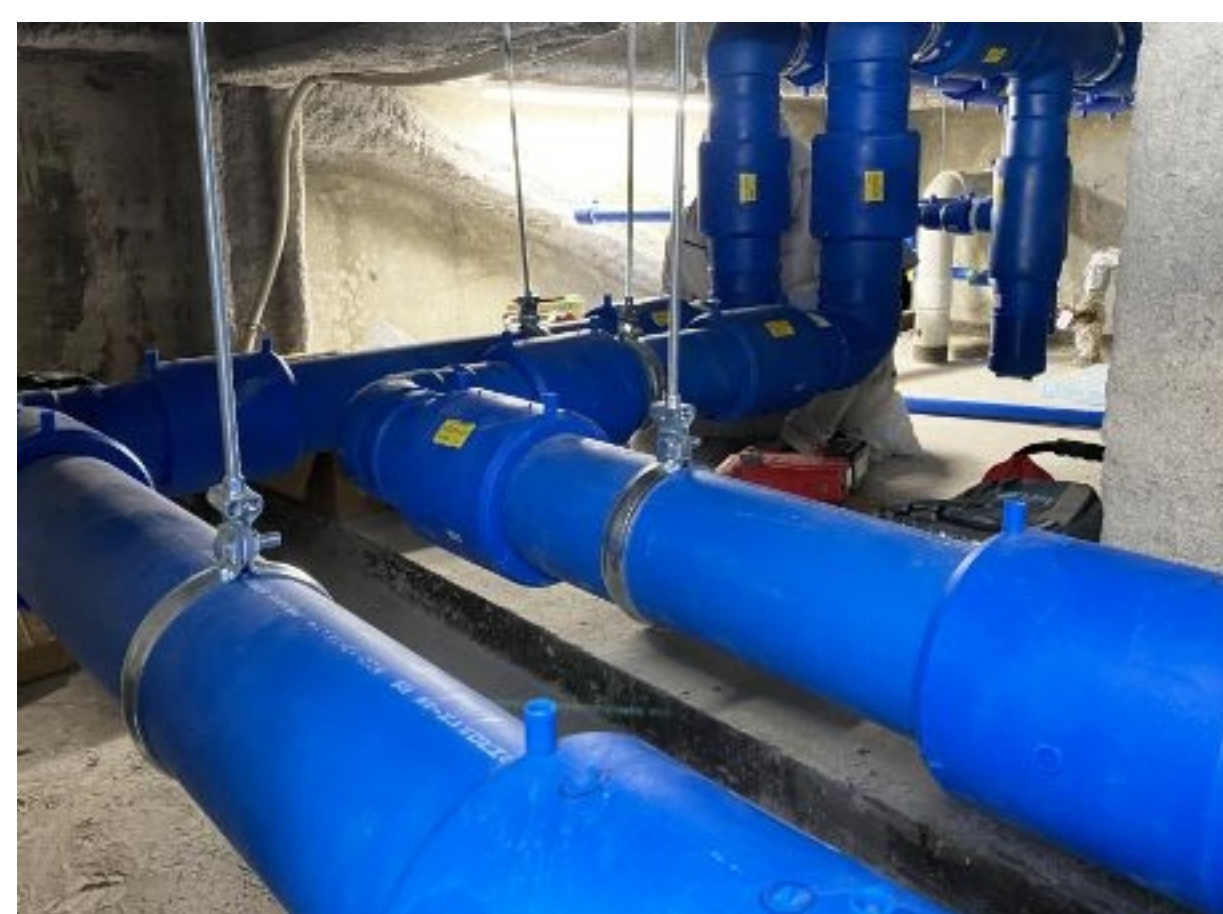
給排水・衛生配管更新工事
