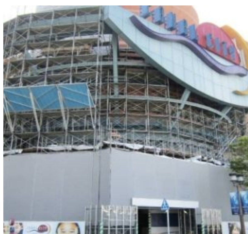
外壁改修工事（キャナルシティ博多）
