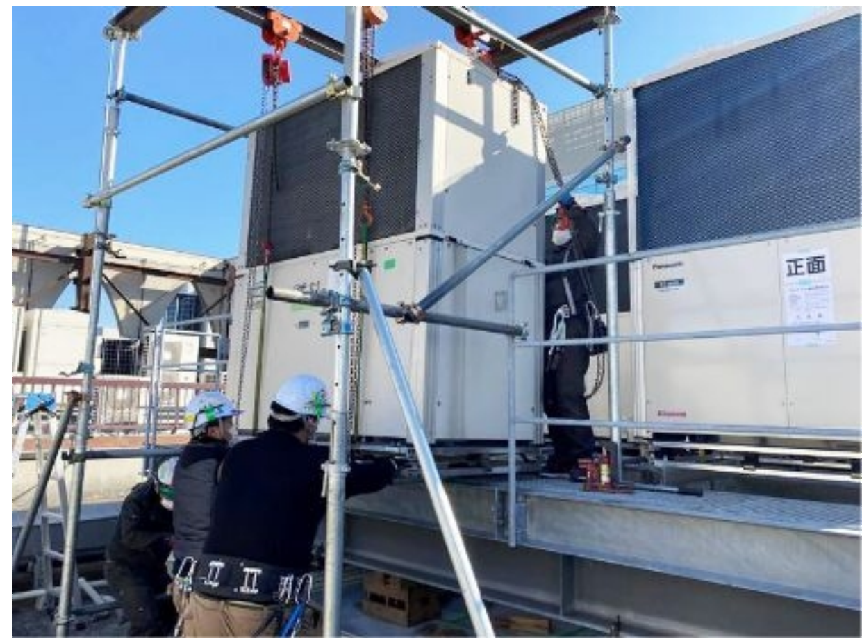
空調設備改修工事
