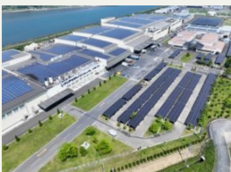
設置方式：屋根置き・カーポート
