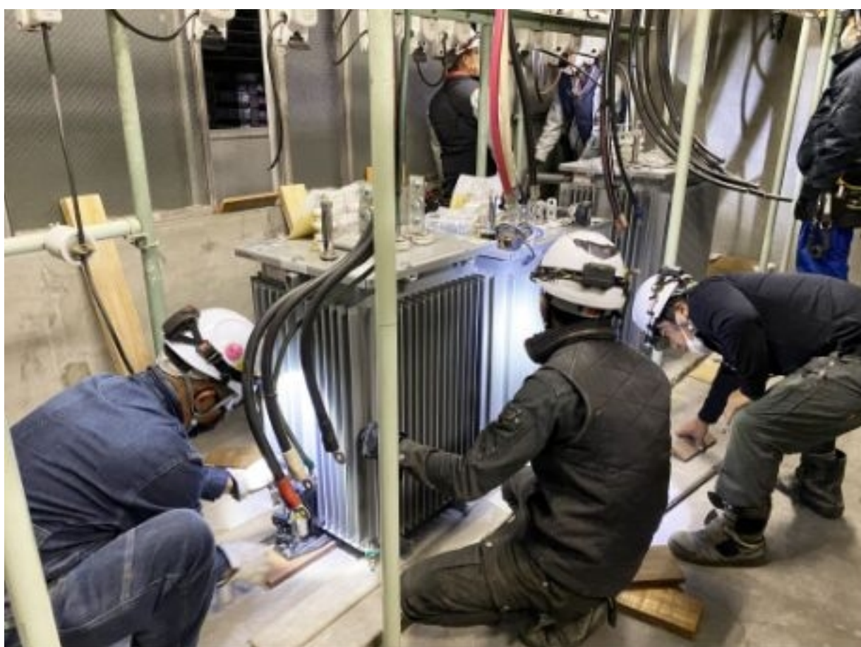
受変電設備更新工事
