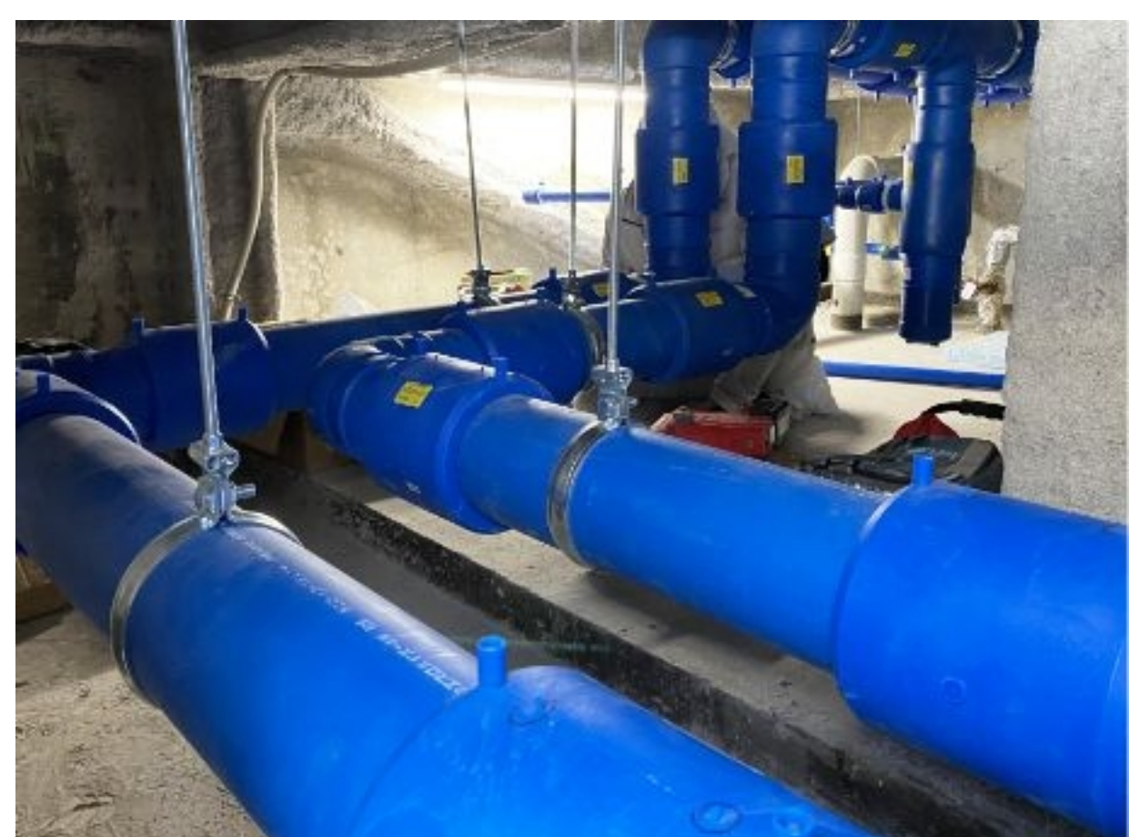
給排水・衛生配管更新工事
