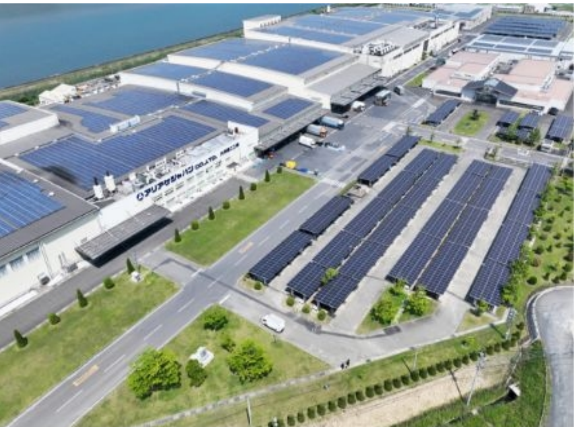
設置方式：屋根置き・カーポート
