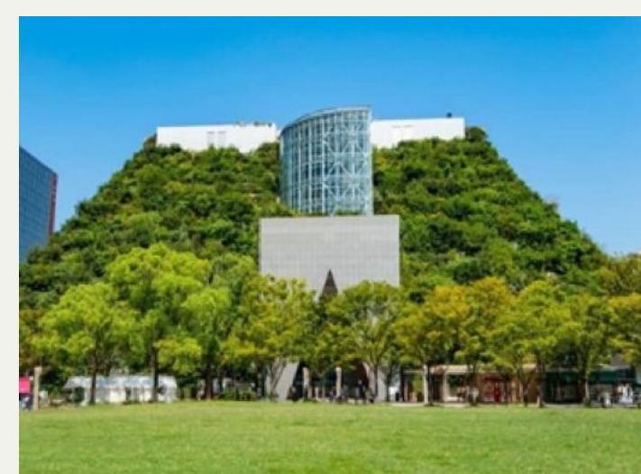
天神中央公園 福岡市中央区
