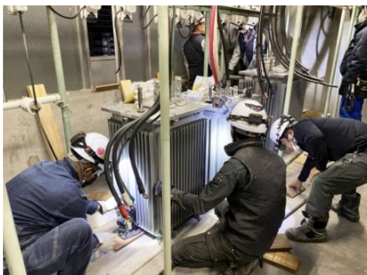
受変電設備更新工事
