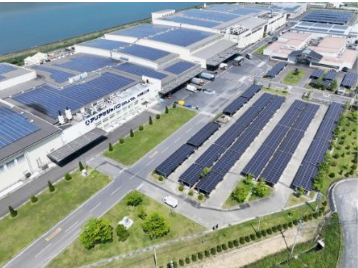
設置方式：屋根置き・カーポート
