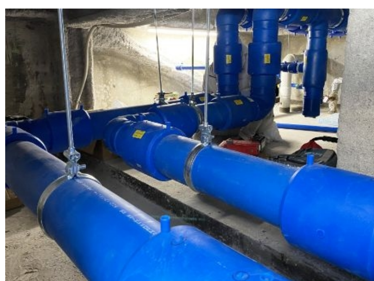
給排水・衛生配管更新工事
