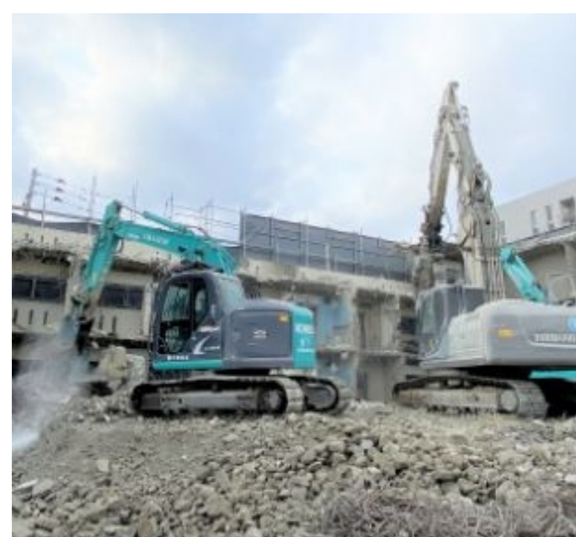
解体工事（某銀行社宅）
