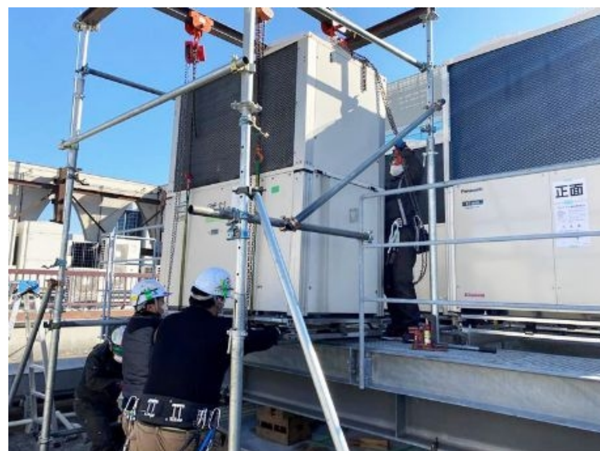
空調設備改修工事
