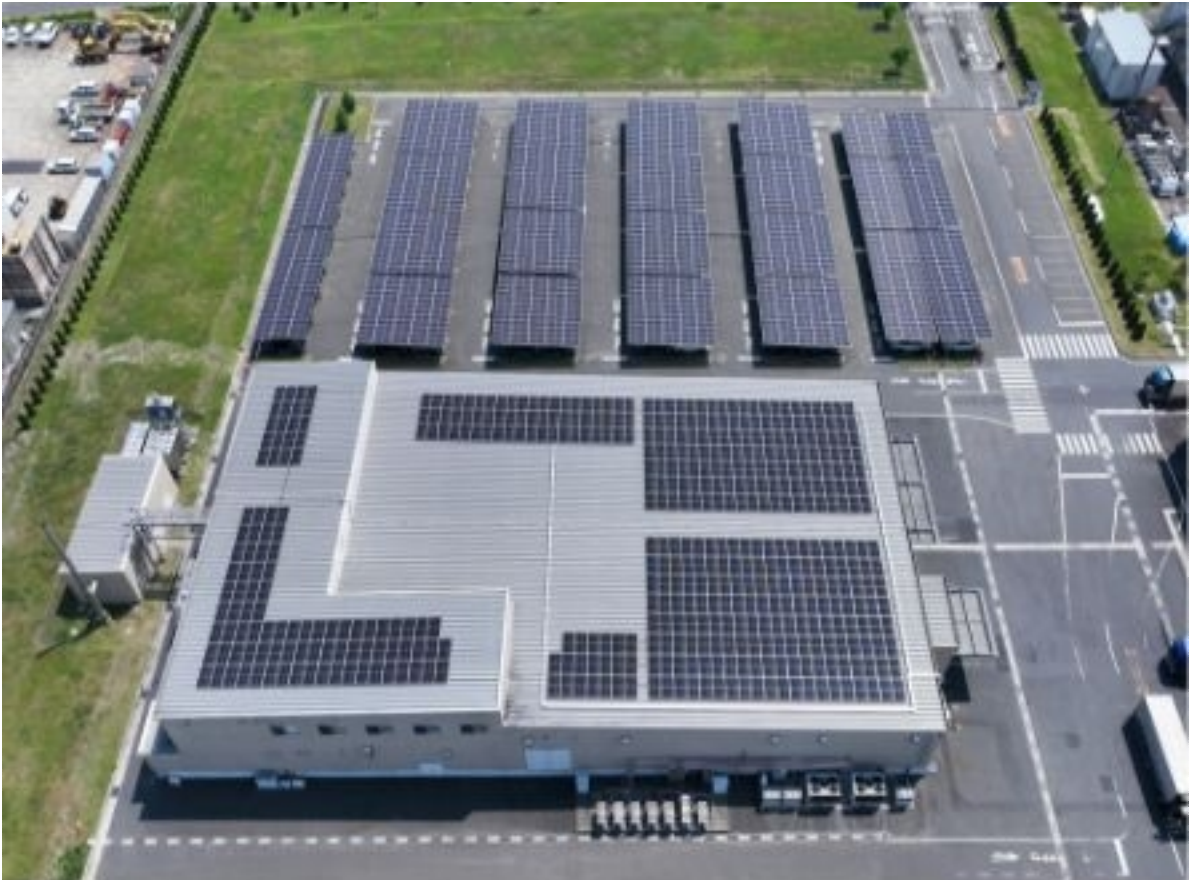
設置方式：屋根置き・カーポート
