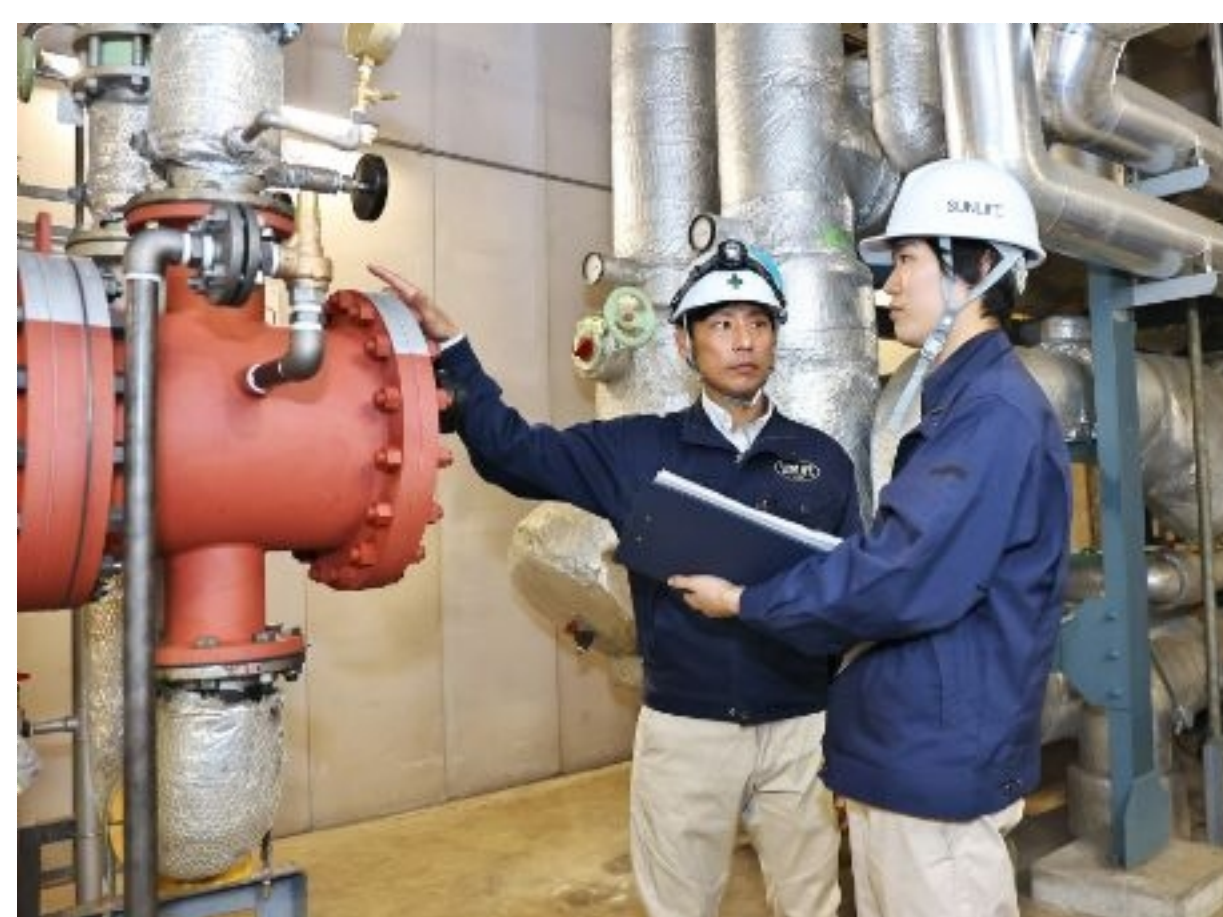
熱源設備改修工事
