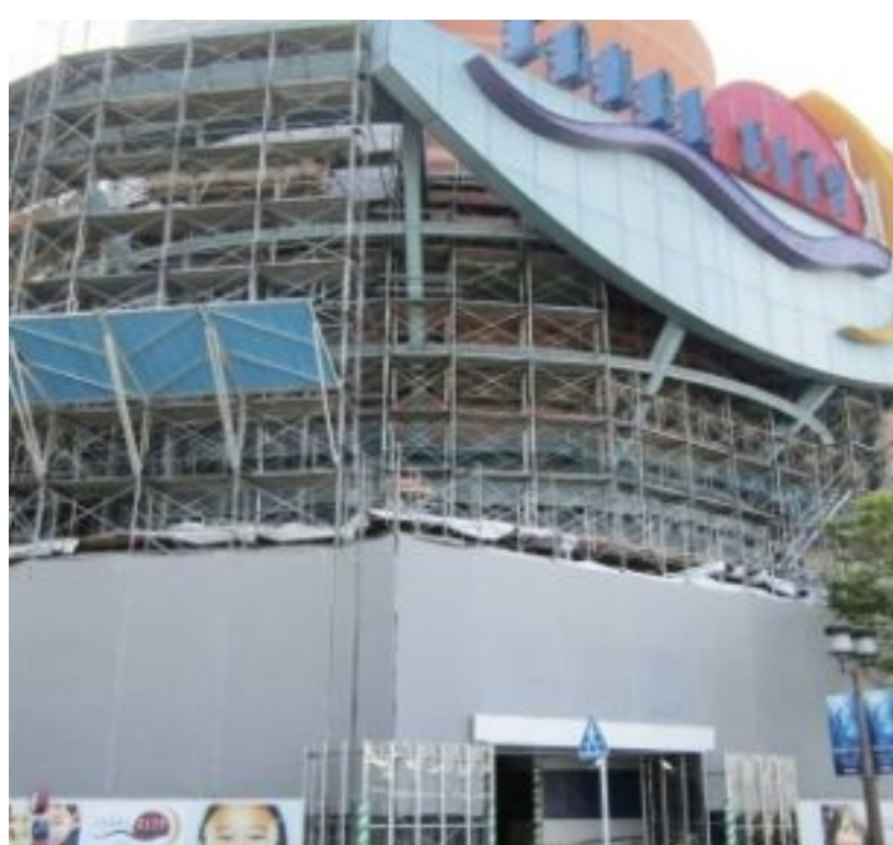
外壁改修工事（キャナルシティ博多）
