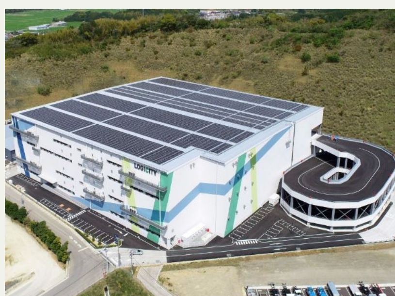
ロジシティ古賀 福岡県古賀市
